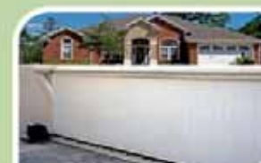
Automatisation de portails
